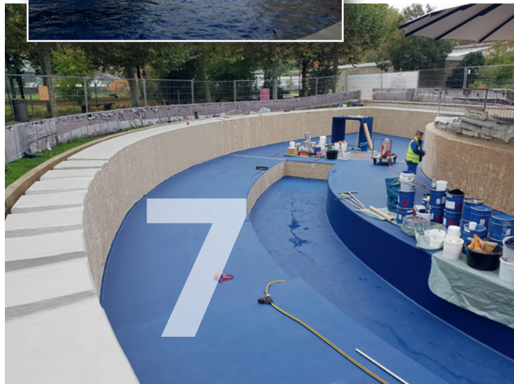
Das Seelöwenbecken in der Stuttgarter Wilhelma wurde saniert und neu beschichtet
