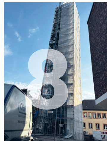
Am Turm der St. Georgen Kirche hat OBRA die Fassade instandgesetzt
