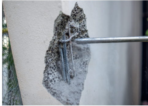
In der Bauwerksanierung und -instandsetzung besteht keine nennenswerte Zurückhaltung bei der Investitionsbereitschaft, erläutert Martin Weihe
